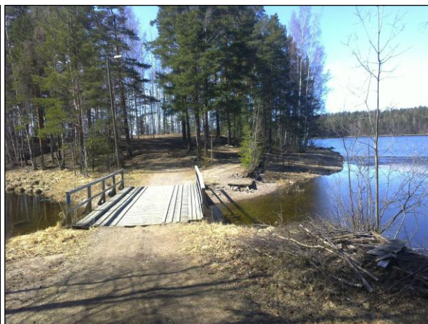
Ukonniemen niemen ja mantereen välinen silta
